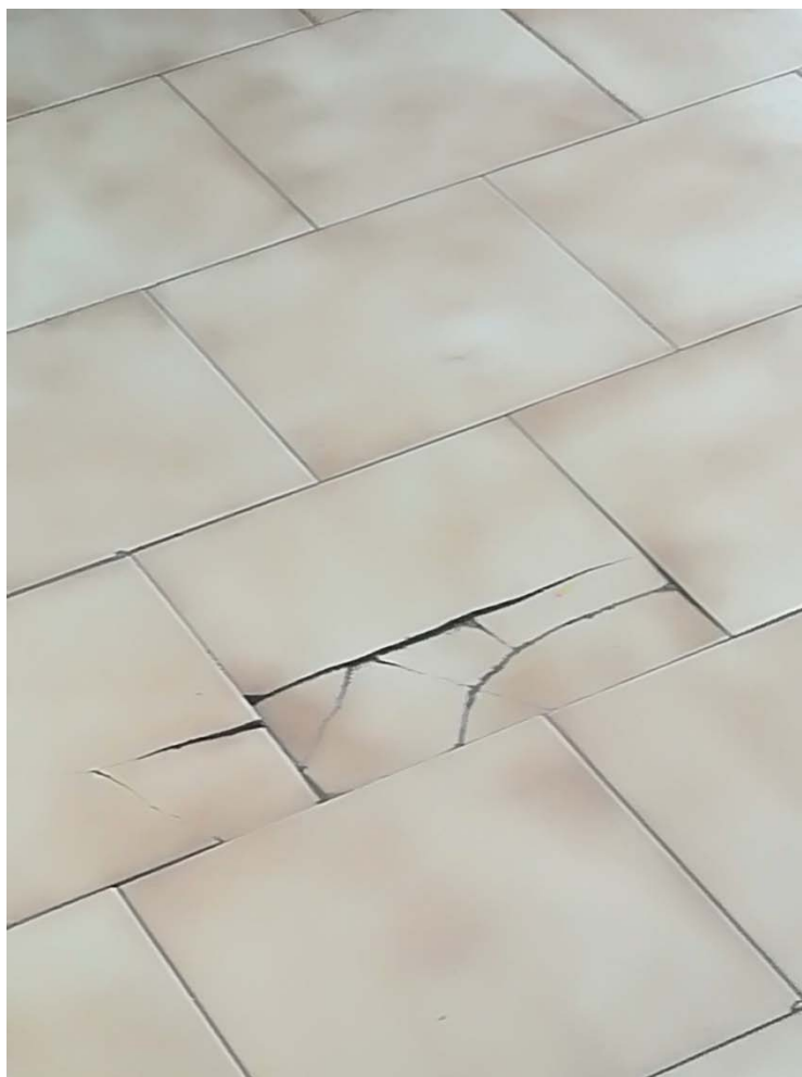
Rifacimento porzioni di pavimentazioni interne
