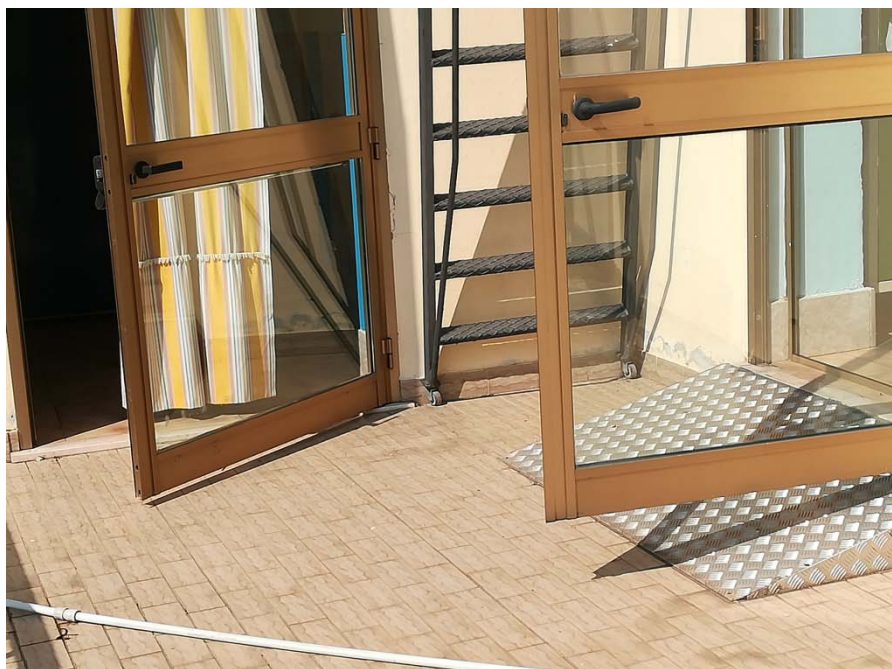
Quota di pavimento da modificare per evitare rampe di uscita verso il terrazzo
