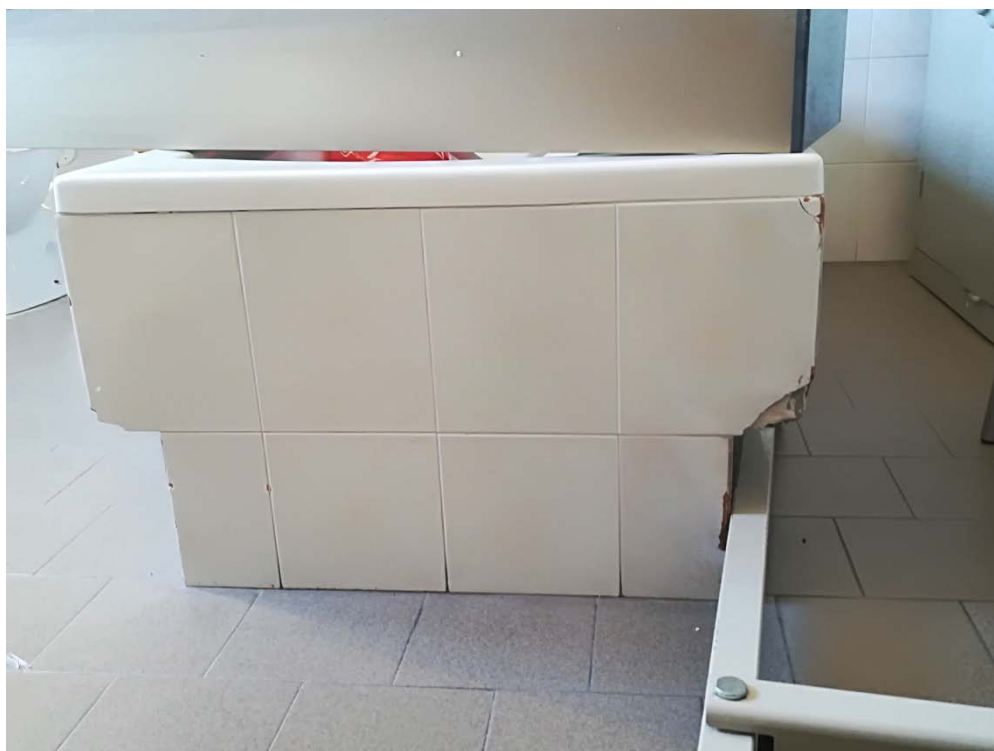
Muratura della vasca all'interno del Bagno Assistito da ripristinare
